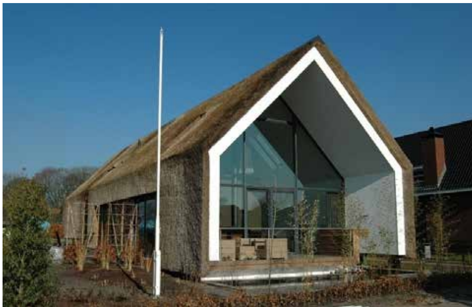
Figuur 17. Hout-staalskeletbouw met verticale rieten gevelbekleding en isolatie van papiersnippers. Foto ARCHES architecten BNA.
