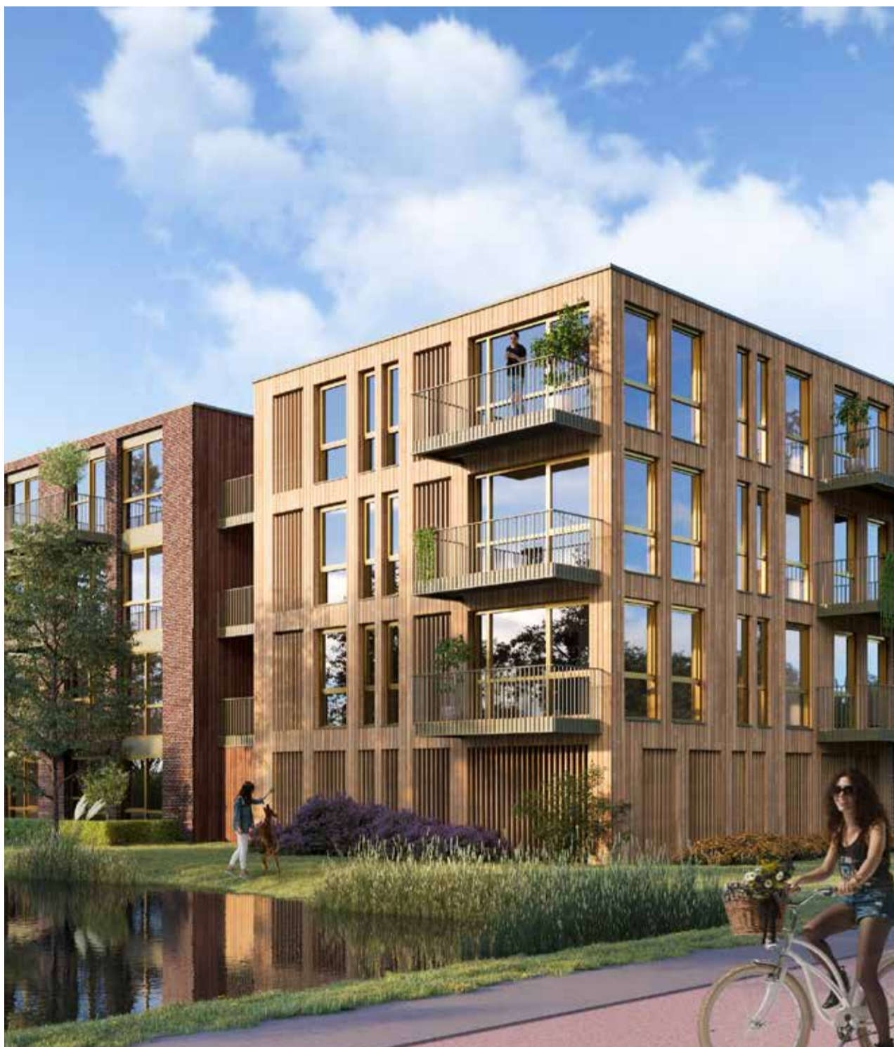
Circulair M'DAM wordt volledig opgetrokken uit CLT (cross laminated timber)
