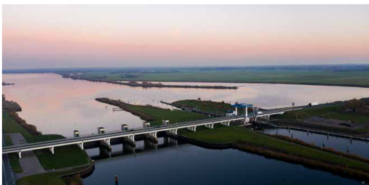
De Nijkerkerbrug. Eén van de praktijkvoorbeelden in de Handreiking Circulair inkopen voor de GWW.
