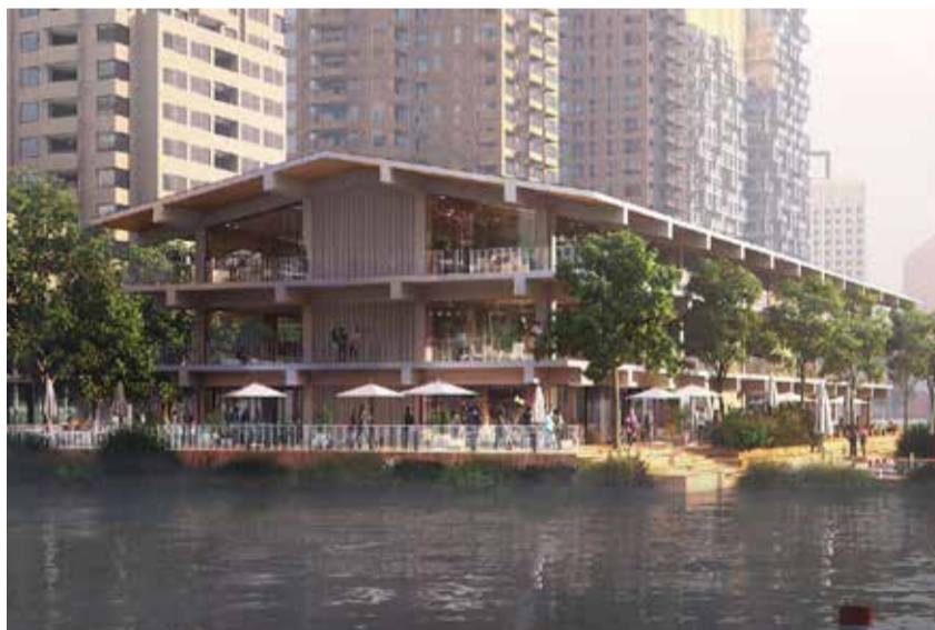
Het Floating Office, Rijnhaven Rotterdam; houten energieneutraal kantoor van het VN Global Center on Adaptation. Met groenverklaring van RVO.
