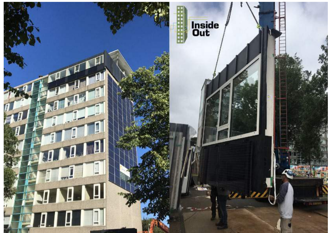
Proefwoning voor het Inside Out project in de Utrechtse wijk Overvecht
