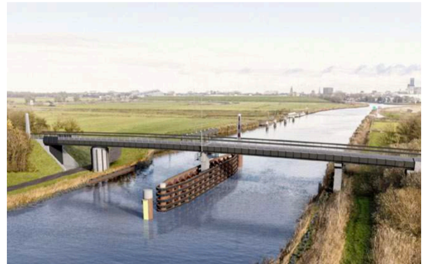
DRIVE, de biobased fietsbrug over het Van Harinxmakanaal
