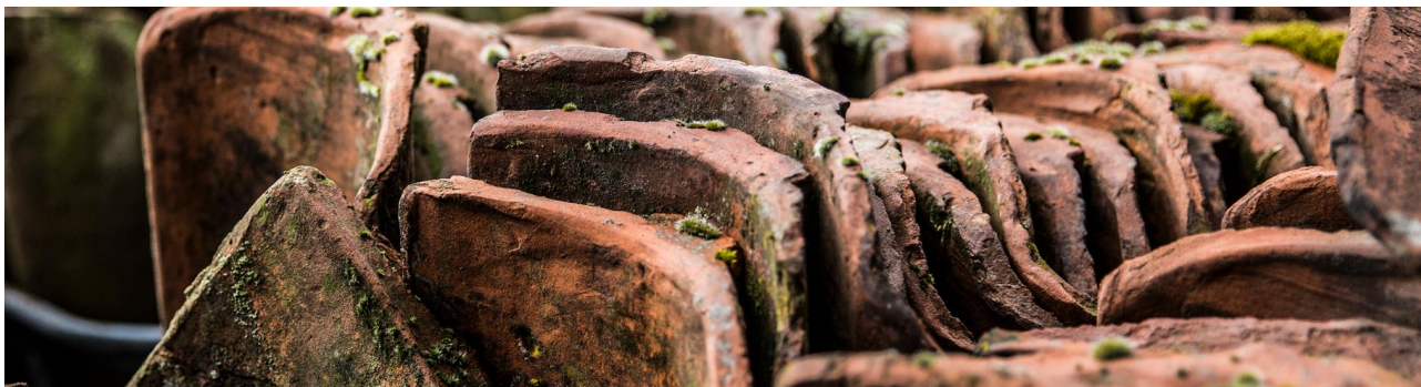
Figuur 21: Circulair gebruik dakpannen (bron: Luijtgarden)
