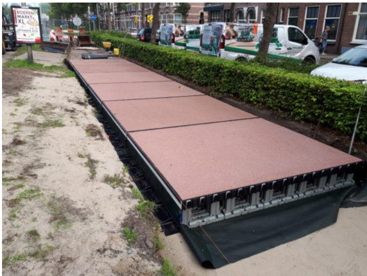
Figuur 34: Inzet van gerecycled kunststof als wegdek (bron: Wavin)
