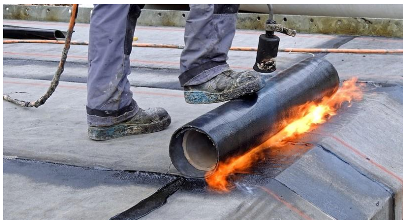
Figuur 20: Aanbrengen dakbanen plat dak (bron: Icopal)
