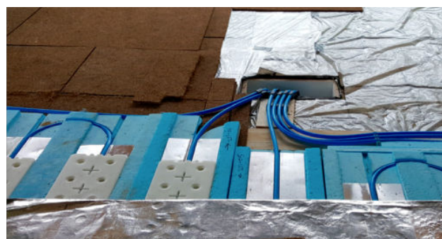
Figuur 14: Foto vloeropbouw
