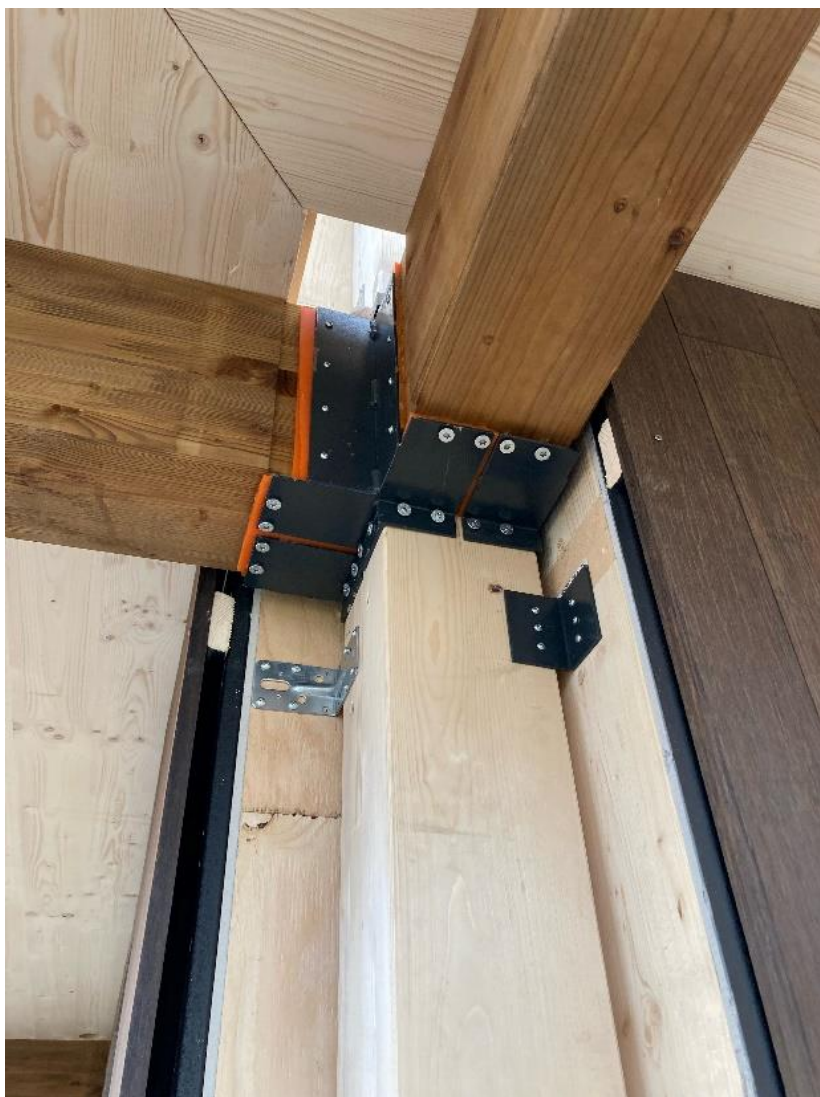
Figuur 28 – Aansluiting consoles (1)
