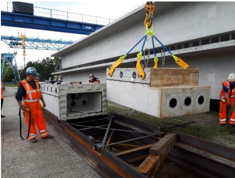
Figuur 38 – Viaduct Kampen (4)
