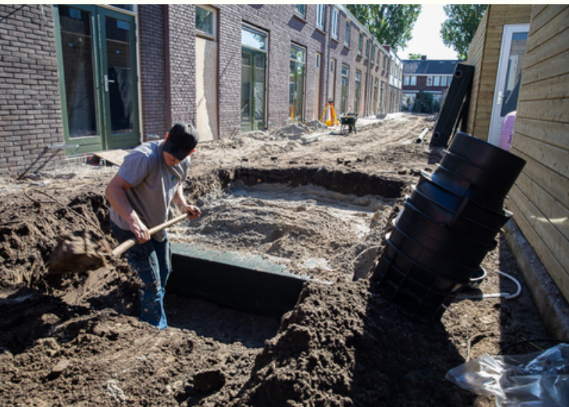
Plaatsing van infiltratiekratten
